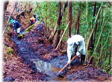
水路に堆積した土砂・枝葉の除去をする 林業部山田副長、甲斐社員、河野社員
