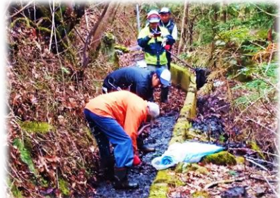
水路に堆積した土砂・枝葉の除去をする 林業部山田副長、甲斐社員、河野社員
