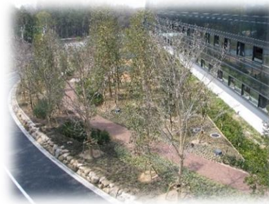
九州国立博物館植栽工事
