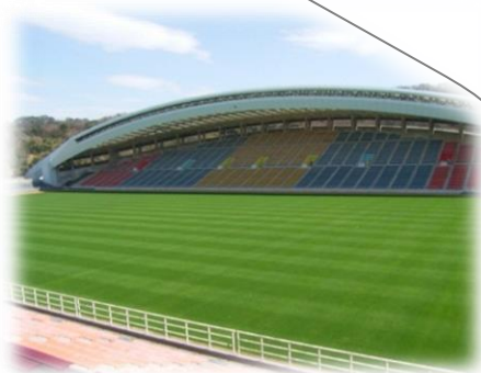
スポーツ施設の緑化工事(東平尾公園)
