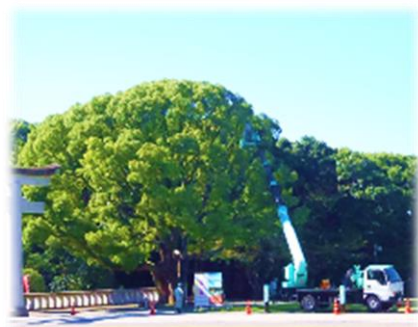
福岡県護国神社 樹木枯枝除去及び樹林内伐採工事
