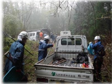
水路に堆積した土砂・枝葉の除去 (林業部副長・山田、永田、日野)
