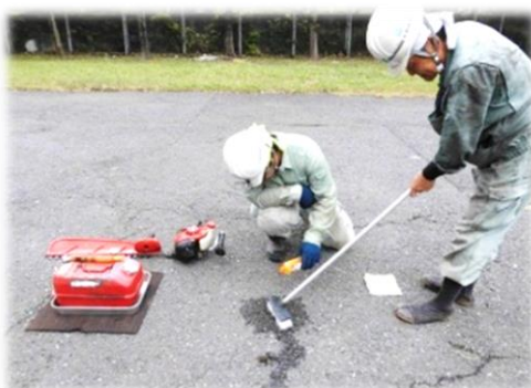
燃料漏れを想定した訓練
