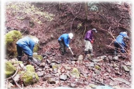
水路に堆積した土砂・枝葉の除去 (林業部副長・山田、永田、日野)
