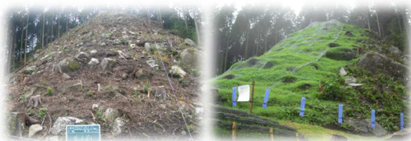
送電線鉄塔敷地保全対策工事施工例
