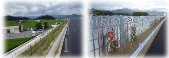
高速道路の造園工事施工例
