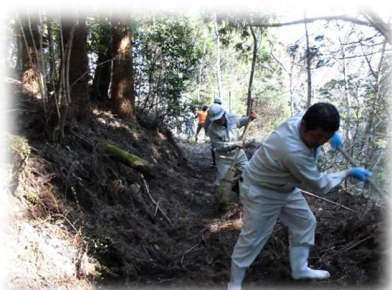
水路に堆積した枝葉の除去 (林業部担当：江藤勝憲)
