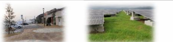
住宅展示場造成工事 大村メガソーラー 芝の吹き付け
