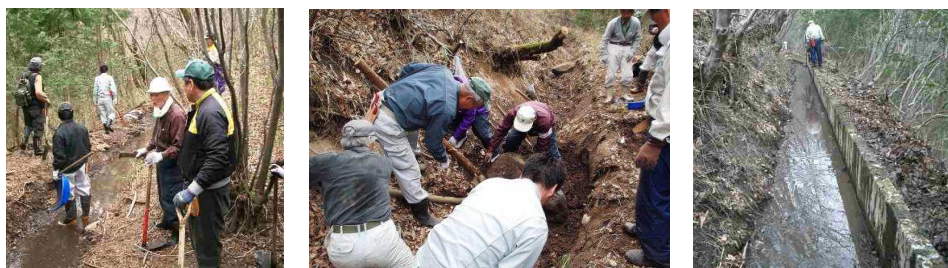
奥江集落における巡視路の草刈・修繕及び水路浚渫作業の様子
